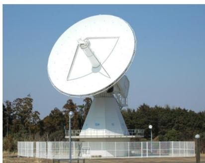
写真-30 茨城県石岡市内に整備中の VGOS 対応 VLBI アンテナ。アンテナ径13.2m。MTメカトロニクス社製(ドイツ)を使用し、東陽テクニカが納入
