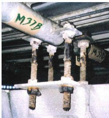
写真-17 アンテナ主反射鏡パネル(上部)を固定するボルトは、腐食が進み、切断一步手前のものもあった
