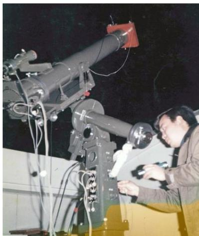
写真-25 GSI 型人工衛星写真赤道儀(鹿野山測地観測所にて。昭和 38 年度配備)。人工衛星(エコーなど)の飛跡を、恒星をバックに写真撮影し、衛星の位置を求めた。本土の観測点と離島などの観測点で同じ衛星を同時に観測し、離島位置の決定などに寄与した。地理院・水路部・東京天文台による共同観測も行われた
